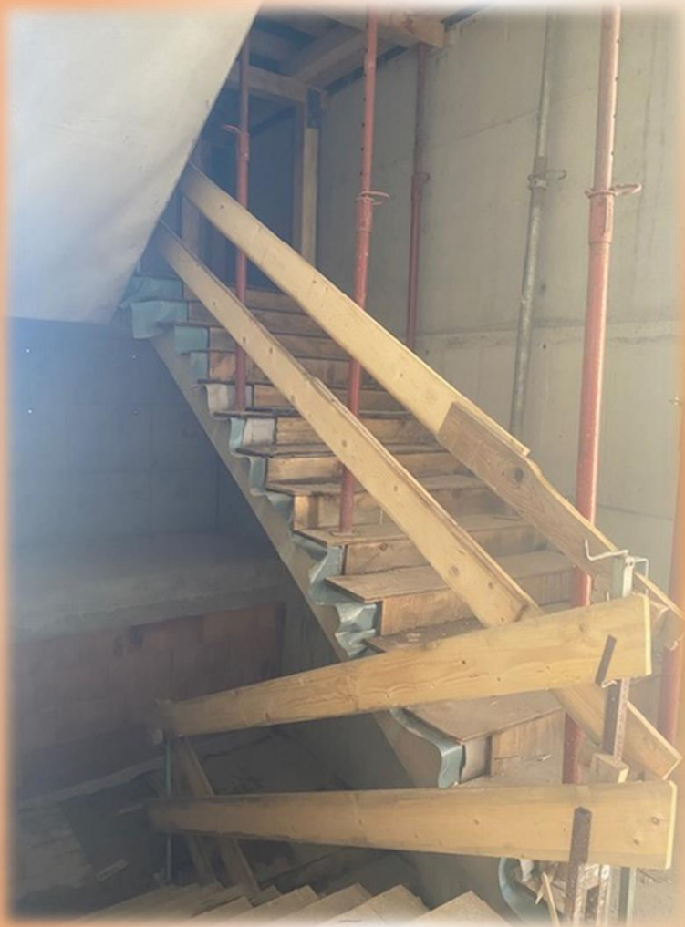
Neues Treppenhaus im Anbau
